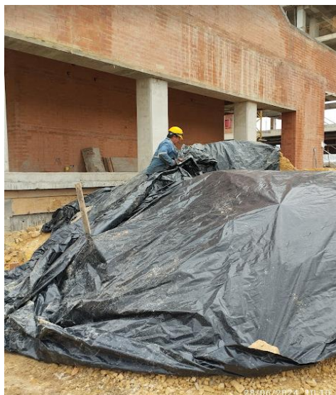
Cubrimiento de material granular. Fecha: 07 -2024
