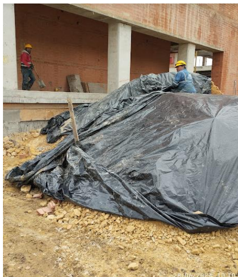
Cubrimiento de material granular. Fecha: 07 -2024
